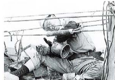
架空ケーブルの接続給電作業(昭和37年頃)
