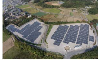
手光発電所 990kw (福岡)
