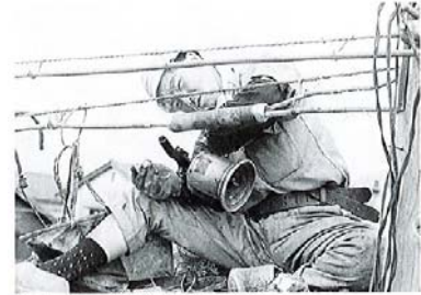
架空ケーブルの接続給工作業 (昭和37年頃)
